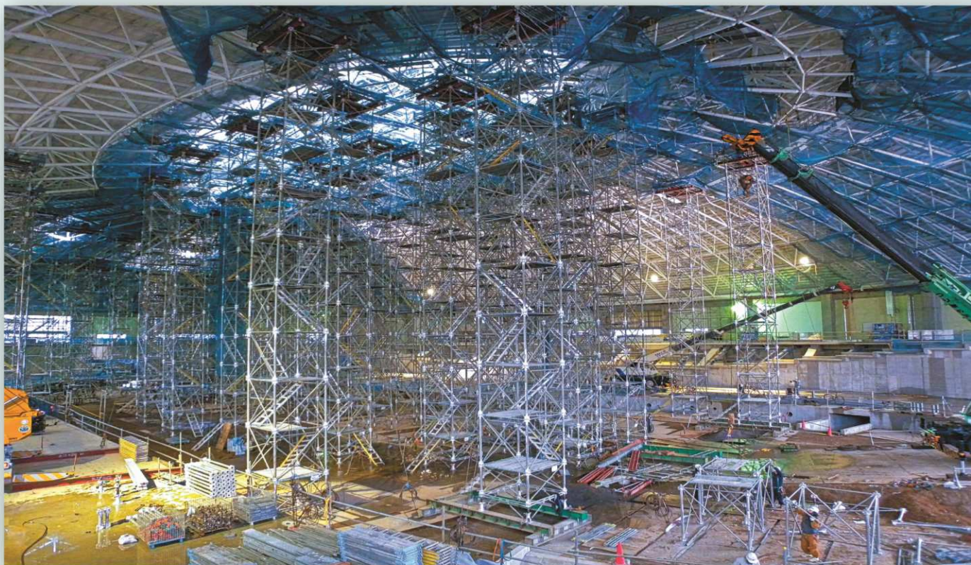
室内競輪場(鉄骨屋根受ベント)
